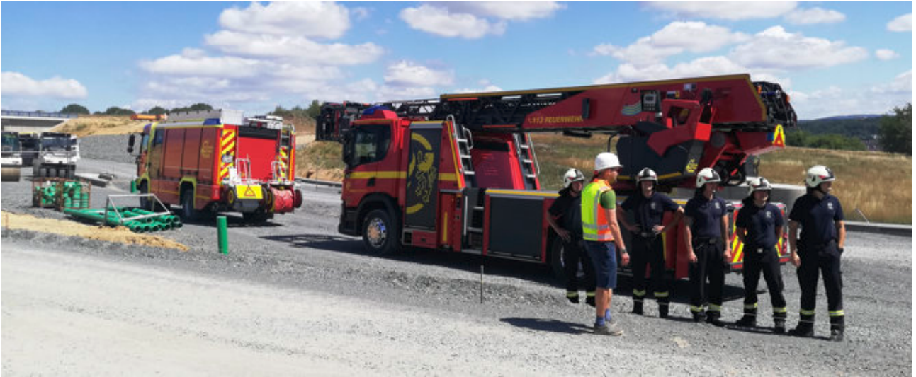
(11) I. Wachabteilung schaut sich im Rahmen einer Objektbesichtigung die Baustelle zur Südumfahrung Pirna an (Foto: Feuerwehr Pirna)
