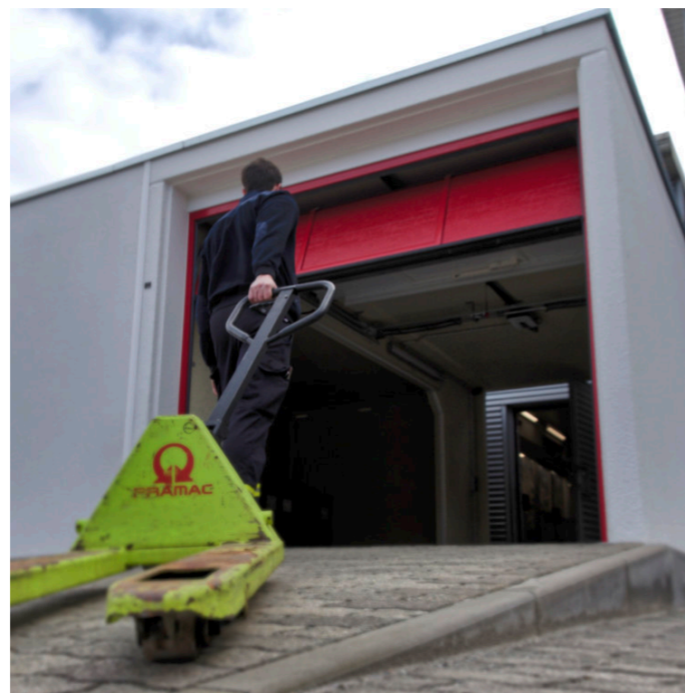
Anbau (Überdachung) der Schlauchwerkstatt (Foto: Albrecht Kempe)
