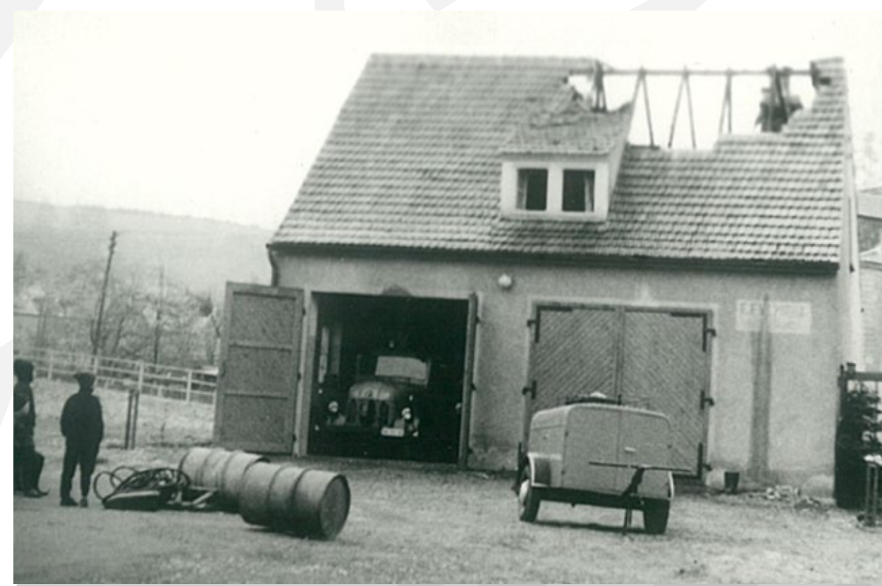
Gerätehaus Neundorf nach Dachstuhlbrand, ausgelöst durch einen Schmelzbrand, 1963. In der Fahrzeughalle steht das in Eigenleistung aufgebaute Löschfahrzeug auf Steyer.
