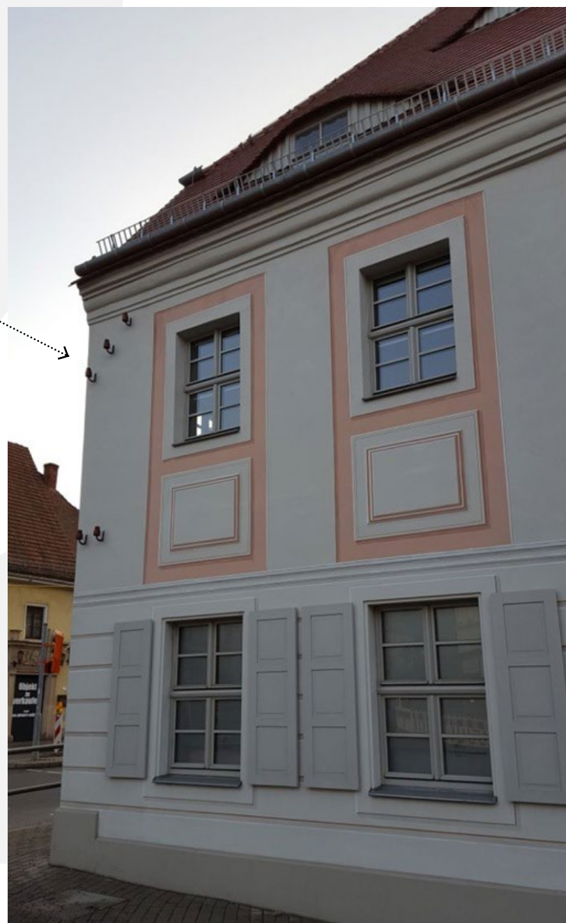
Reste des alten Feuermeldersystems am Haus Breite Straße 2 (Foto: FF Pirna)
