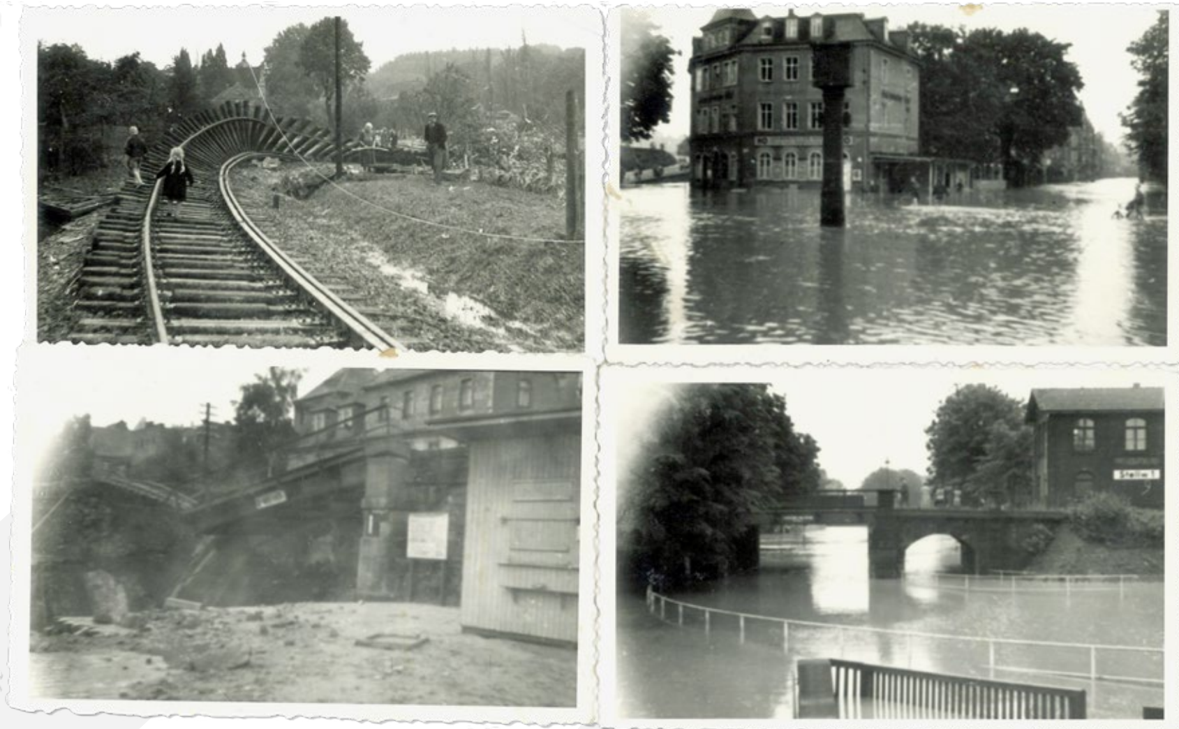
Zerstörungen und Überflutungen durch das Gottleuba-Hochwasser 1957
