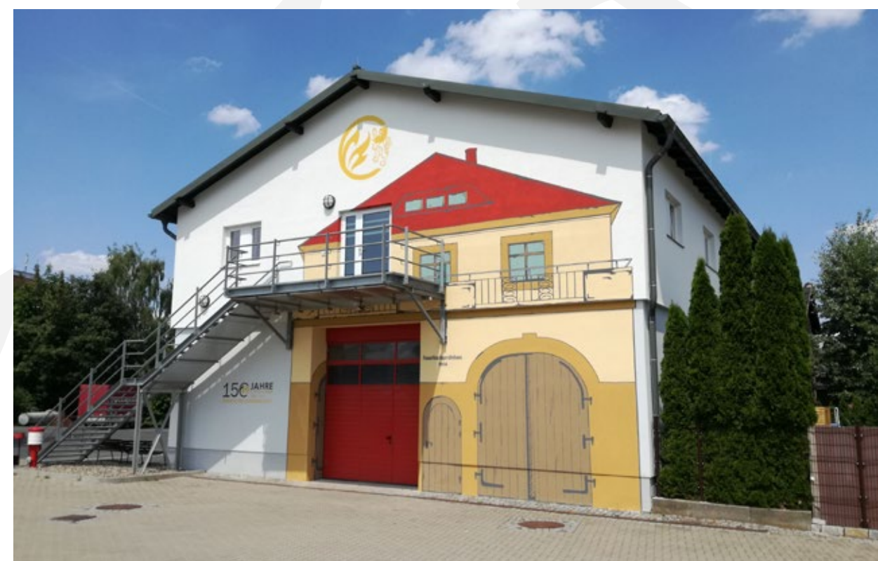
Das Gebäude mit der Atemschutzübungsanlage präsentiert sich seit der 48-Stunden-Aktion der Jugendfeuerwehr in diesem Jahr in neuem Gewand und erinnert nun an das alte Gerätehaus an der Oberen Burgstraße
