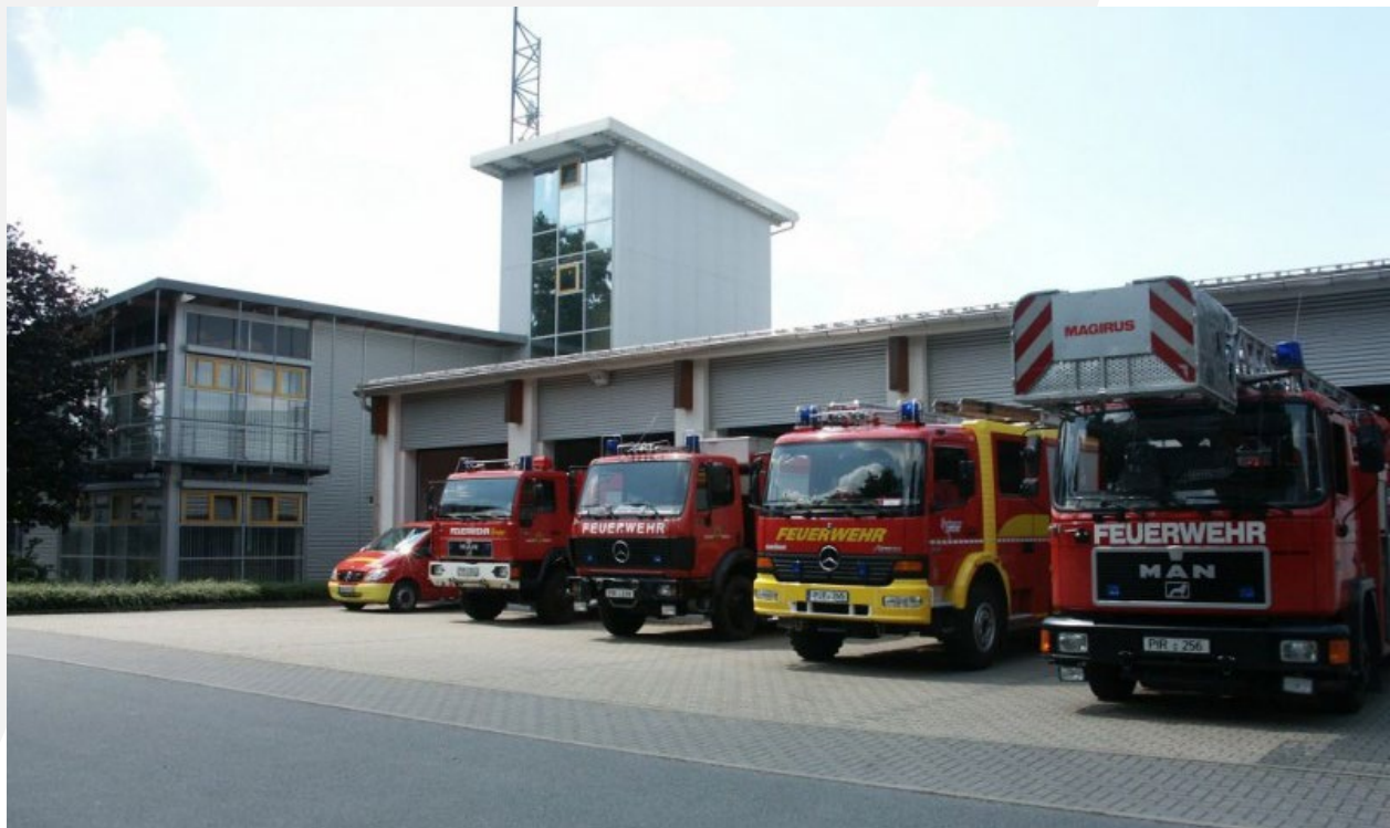
Hauptfeuerwache Pirna nach der Eröffnung mit Einsatzfahrzeugen
